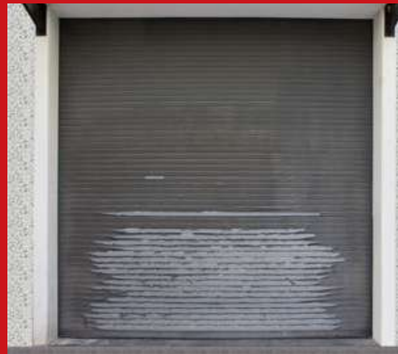
Serranda in acciaio rivestita in PVC esposta alle intemperie
